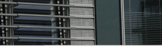
Detail der modernisierten Fassade. Neckermann-Rechenzentrum, Frankfurt
